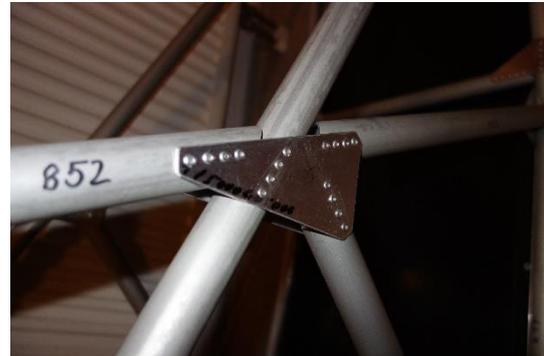
Abb. 7.5: Detailansicht einer Nietverbindung des Gitterrohrrahmens
